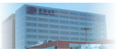
北京泰德廠房
